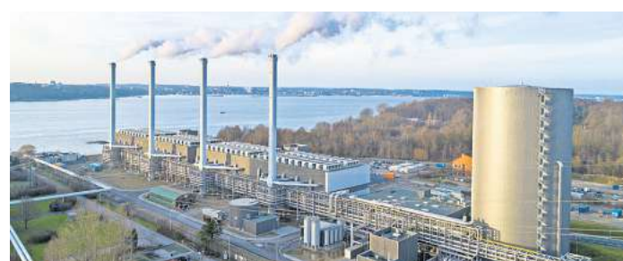
Auch das Küstenkraftwerk soll zum Klimaschutz in Kiel beitragen. Es produziert 70 Prozent weniger Kohlendioxid als das alte Steinkohlekraftwerk.
